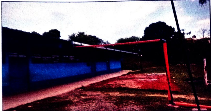
Foto 1: SUSTITUCION BAJADAS FLUVIALES
