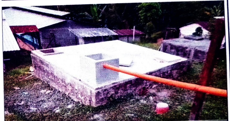
Foto 4: MANTENIMIENTO DE PILA INTERIOR Y EXTERIOR
